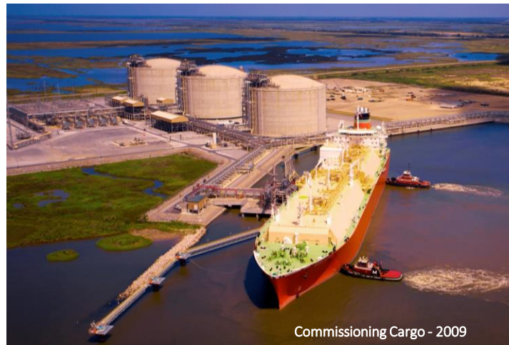
Cameron LNG Regas Terminal
