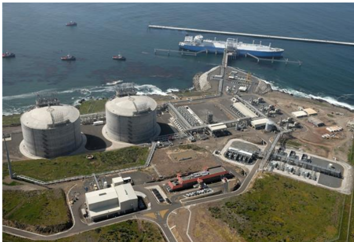
ECA LNG Regas Terminal
